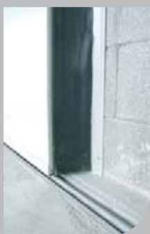
Junta hermética posterior inferior.
