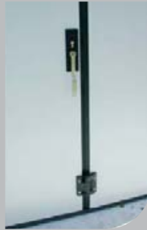
Pasador con cerradura en lado exterior.
