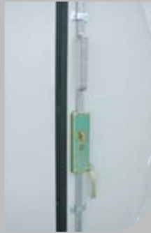
Pasador con cerradura en lado interior.
