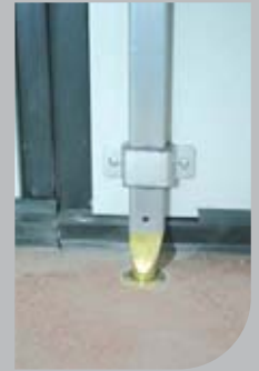
Puntal inferior revestido de teflón.
